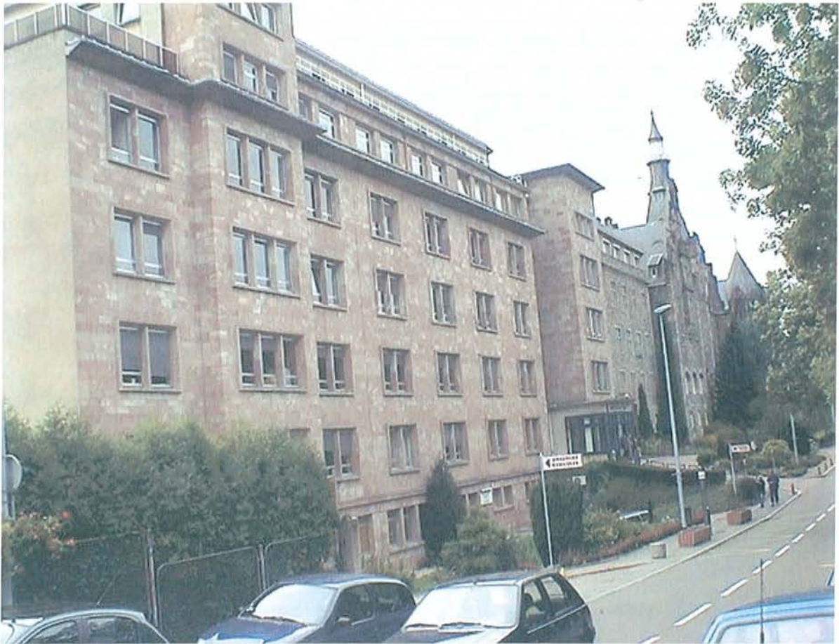
FACADE NORD DE L'HOPITAL : Rue de l'Hôpital.
