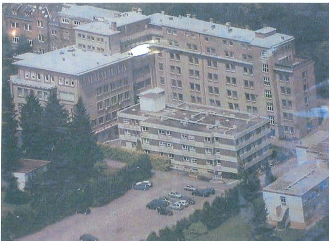
FACADE SUD DE L'HOPITAL
