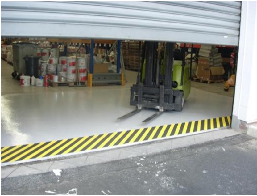
Figure 2: Exemple de marquage au sol de zone dangereuse avec un contraste noir/jaune (d'après www.hellopro.fr )
