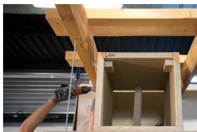
Figure 19 : Système Glasroc de gaine de désenfumage.
