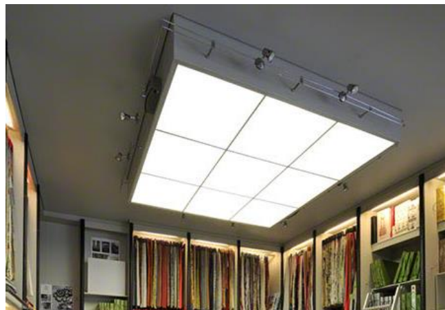
Figure 26 : Plafond Barrisol dalles
