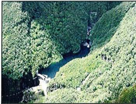
Photo 60 : barrage EDF à la sortie de Takamaka 1 er partie.
