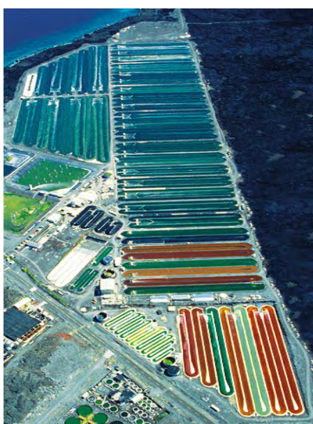
Photo des bassins de production de micro-algues de la société Cyanotech situés sur les côtes Hawaïenne
