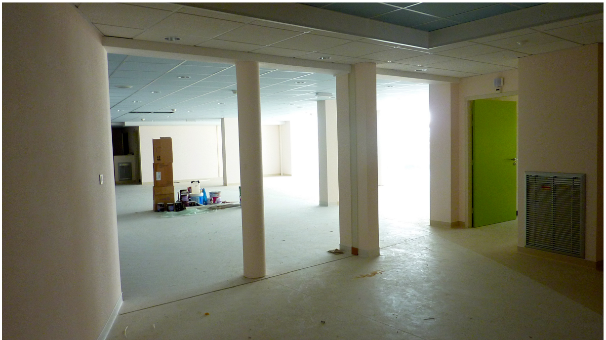
Figure 18 : UVP St Rémy - Vue de la salle de vie depuis les chambres
