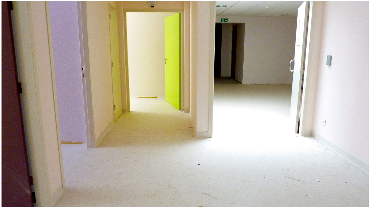
Figure 19 : UVP St Rémy - Vue du couloir à partir duquel les chambres sont distribuées
