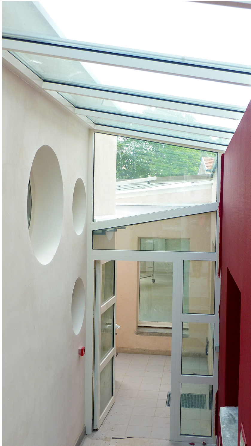
Figure 25 : UVP St Rémy - Couloir d'accès à la salle de Balnéothérapie
