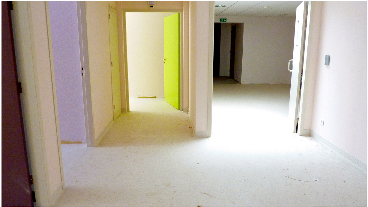
Figure 19 : UVP St Rémy - Vue du couloir à partir duquel les chambres sont distribuées
