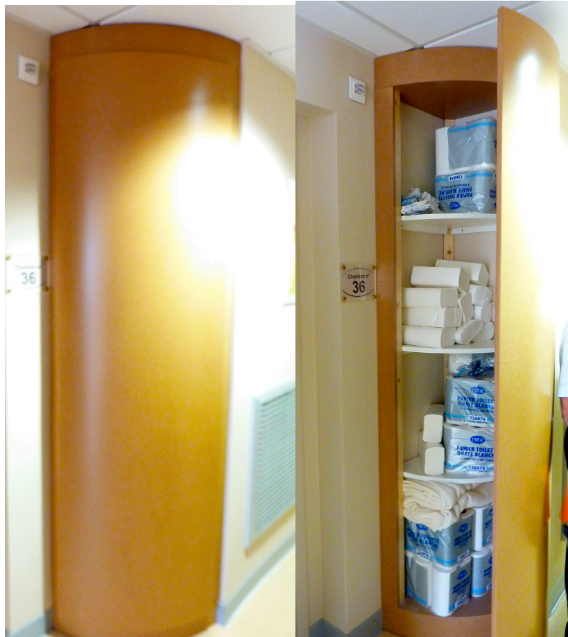
Figure 31 : UVP St Charles - Les placards intégrés au mur sont de forme arrondie afin d'éviter que les patients ne se cognent
