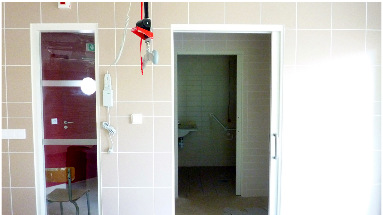
Figure 29 : UVP St Rémy - Vue de la salle-de-bain et des sanitaires annexés à la salle de Balnéothérapie
