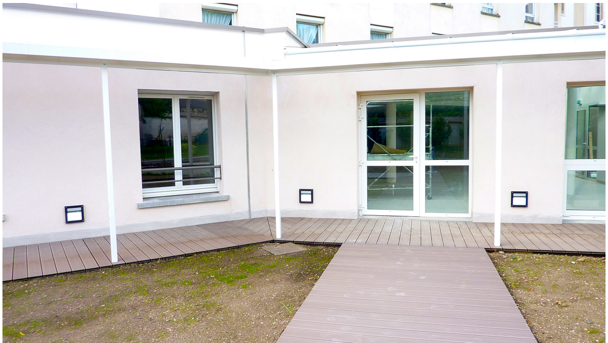
Figure 24 : UVP St Rémy - Vue de l'unité depuis le parcours de déambulation extérieur
