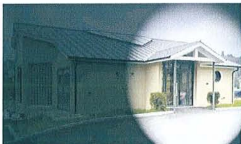
Eclairage latéral par les baies vitrées de l'entrée. et par une ouverture murale circulaire.
