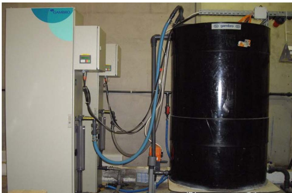
Figure 25 : Osmoseurs et cuve de stockage
