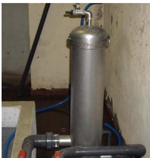
Figure 26 : Filtration stérilisante sur filtre 0,22  $\mu\text{m}$
