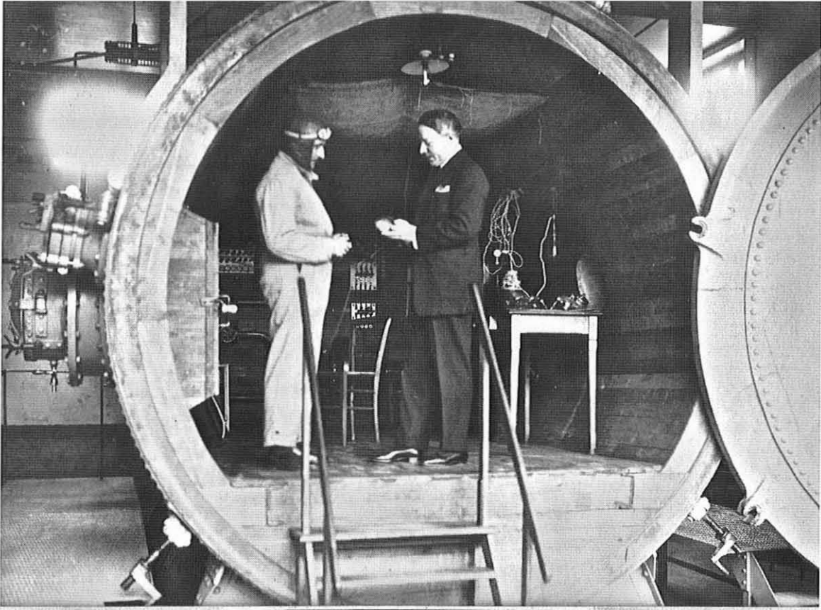
CAISSON PNEUMATIQUE DU BOURGET 1922 - 1940
