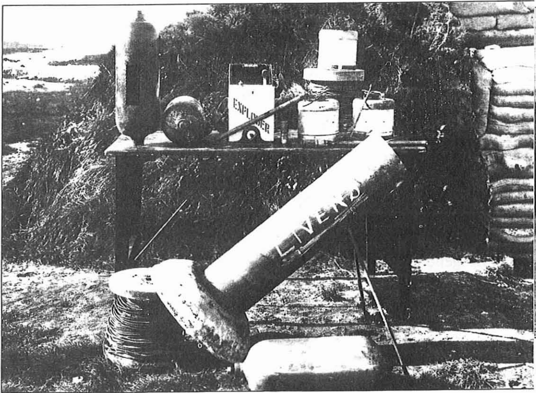
Fig. 6 Projecteur à gaz Livens présenté avec tout son matériel de mise en place et de tir : charges explosives, obus à la forme caractéristique, charges de poudre et fils électriques de mise à feu (IWM).
