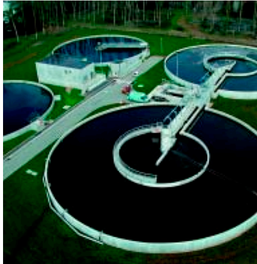
Figure N°4 : Photo aérienne d'une STEP
