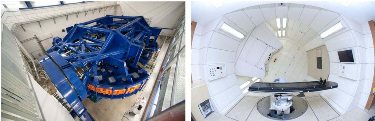
**Figure 65 : Le gantry du HIT : à gauche, vue de l'armature ; à droite, vue de la salle de traitement achevée.**
