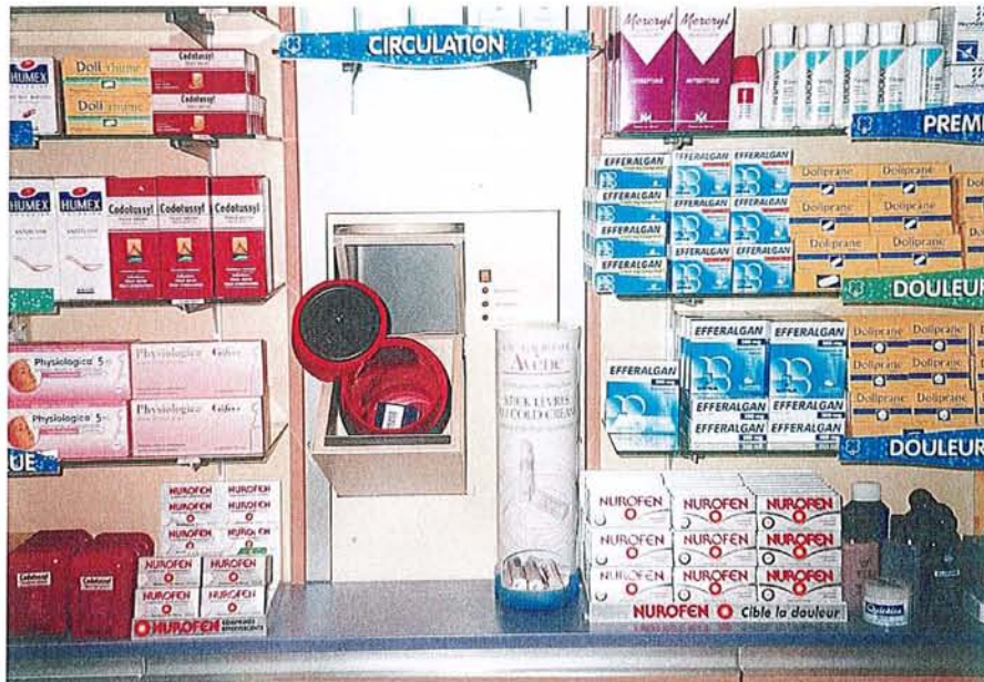
Figure 7 : Point de réception au comptoir du système TELELIFT® (Source : Cliché personnel)
