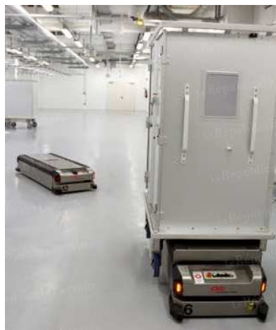
Figure 7 : "Tortues" du système de transport lourd automatisé, avec et sans armoire de transport
