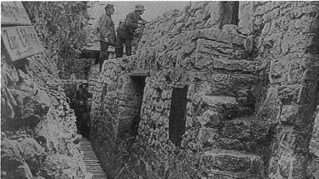
Figure 3 : Photographie d'un ouvrage allemand dans les Vosges. [1]
