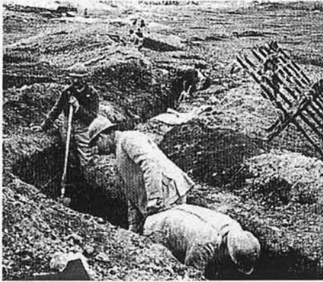
Figure 5 : Hommes en deuxième ligne en train de creuser une tranchée [24]
