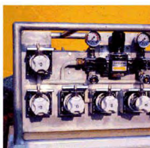
Figure 115 : Module de distribution collective
