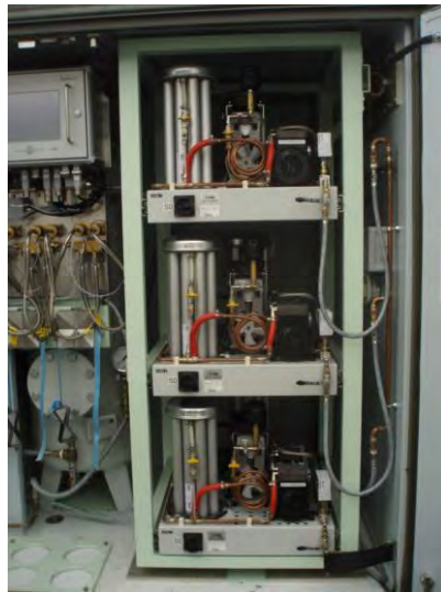
Figure 67 : modules ATF du Module de Suppléance®
