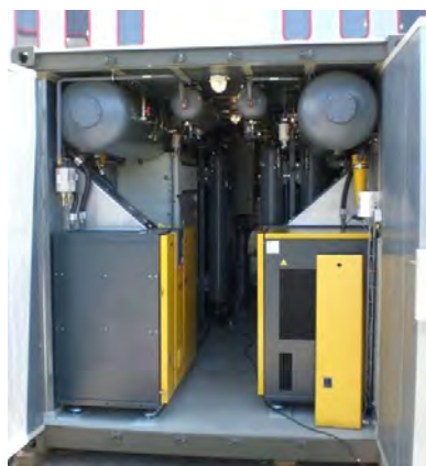
Figure 55 : entrée du MPOGC
