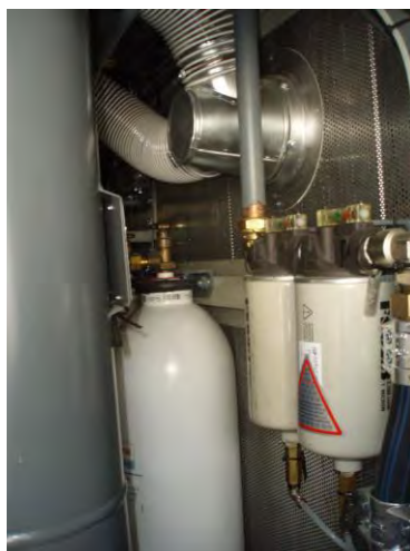
Figure 61 : bouteille du back up interne et filtres bactériens
