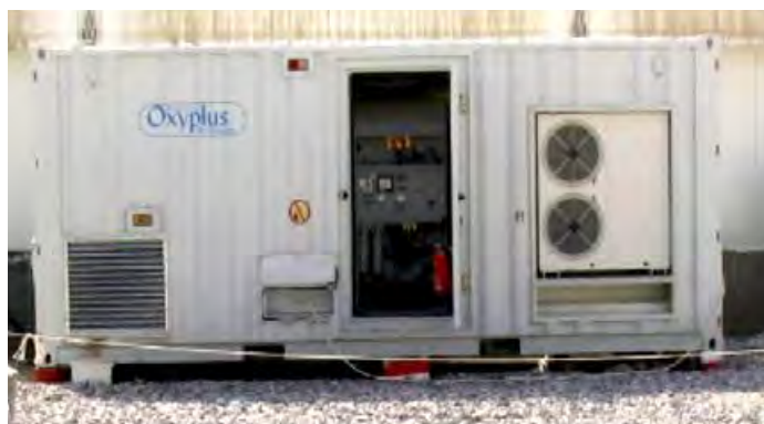
Figures 43 et 44 : Générateur Oxyplus 300 ® (entrée et zone de remplissage des bouteilles)
