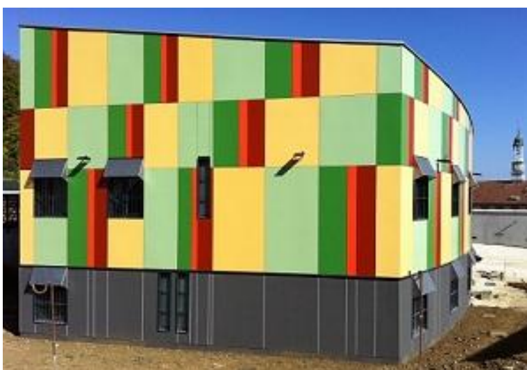
Annexe 13 : UHSA en construction.
