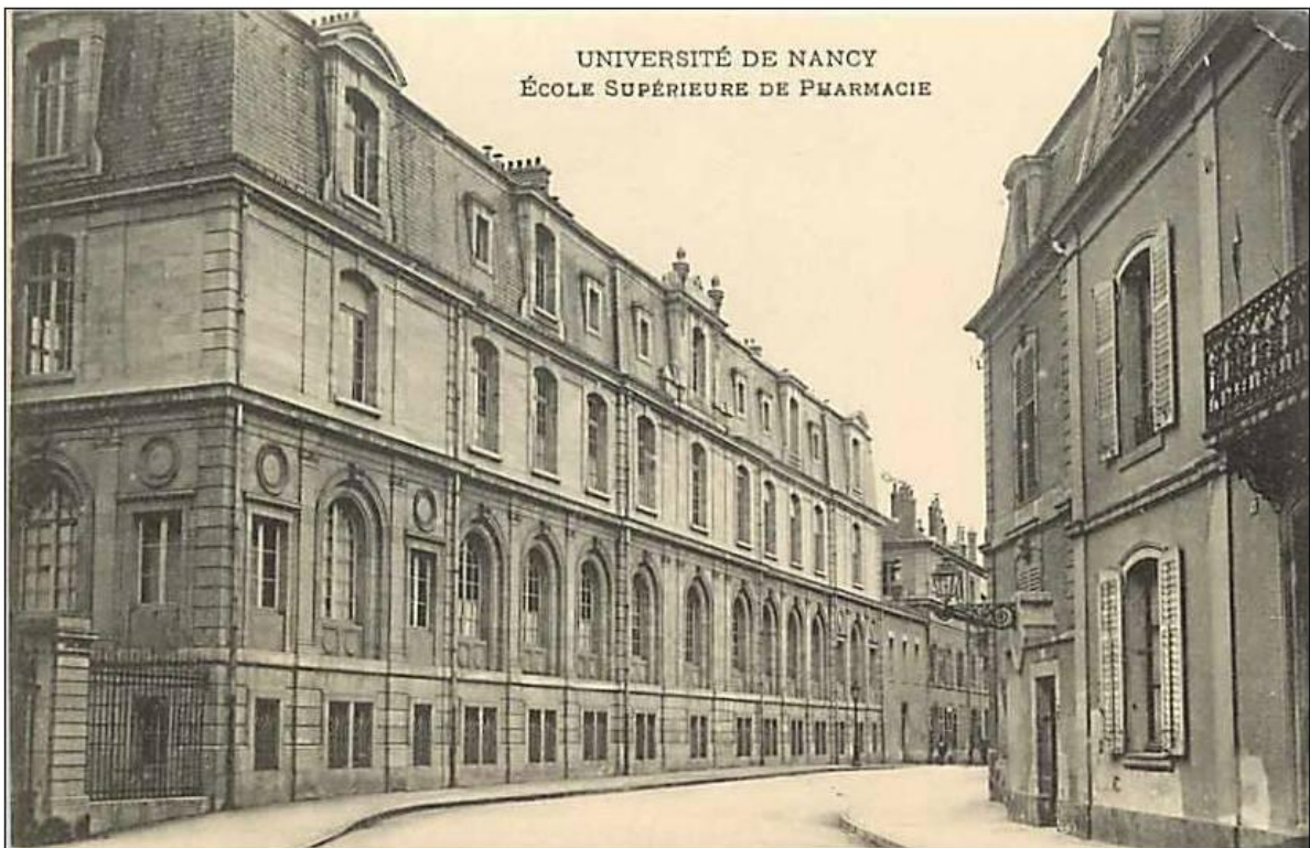
FIGURE 28 : ECOLE DE PHARMACIE APRES LES TRAVAUX (62)
