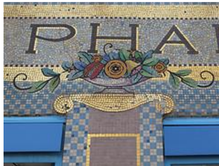
FIGURE 76 : DETAIL DE LA FAÇADE (106)
