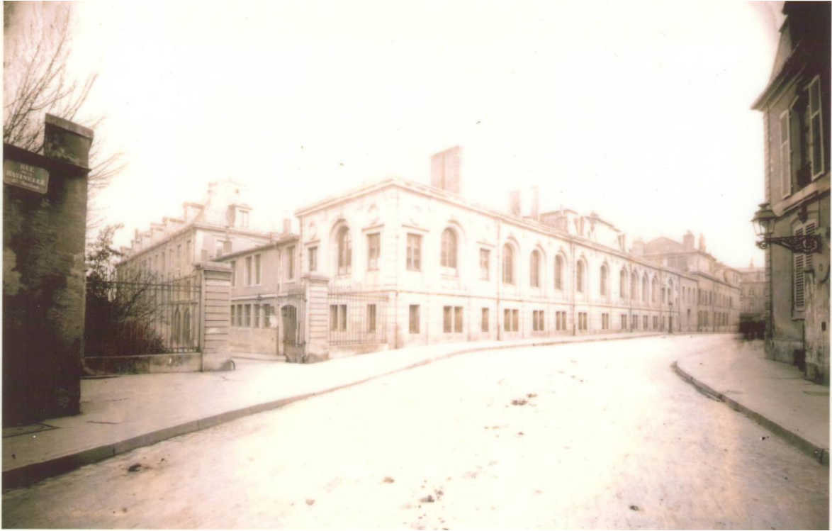
FIGURE 27 : ECOLE DE PHARMACIE AVANT LES TRAVAUX DE REHAUSSEMENT (15)
