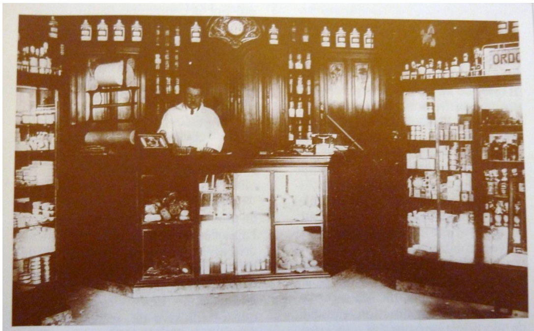
FIGURE 77 : INTERIEUR DE LA PHARMACIE DU POINT CENTRAL (102)
