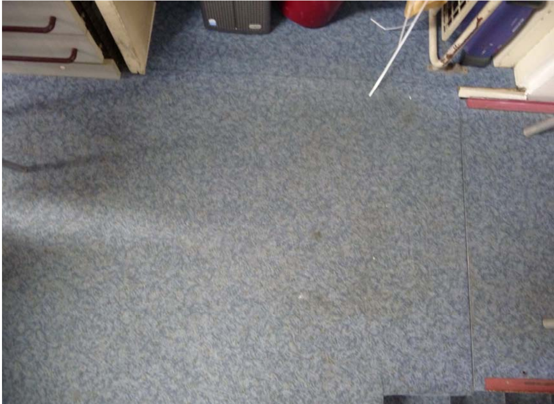
Figure 47 - L'espace de manœuvre au sol devant le poste informatique et le monte-charge.
