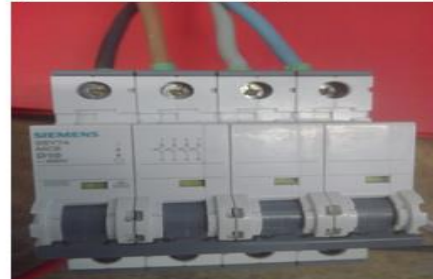
Disjoncteur tétrapolaire (3 phases + neutre)
