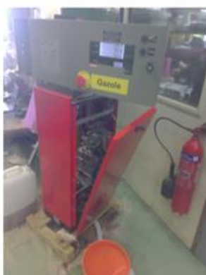
vue d'extérieure Cablage consigne
