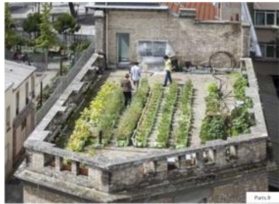
Figure 3 : Toiture du collège Henri-Matisse à Paris (20e)
