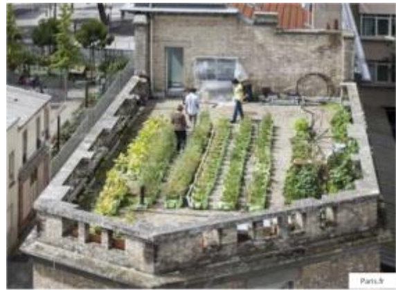
Figure 3 : Toiture du collège Henri-Matisse à Paris (20e)
