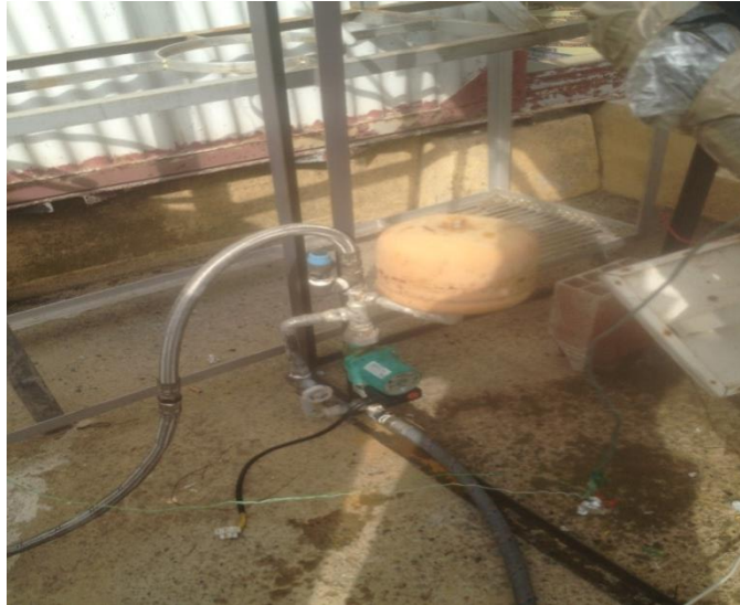
Figure (5-9) : Régulateur de débit (pompe)
