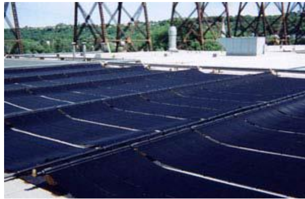
Figure (2-16) : Capteurs plans sans vitrage [17]
