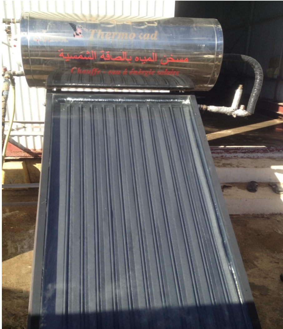
Figure (5-2) : Le capteur solaire plan étudié
