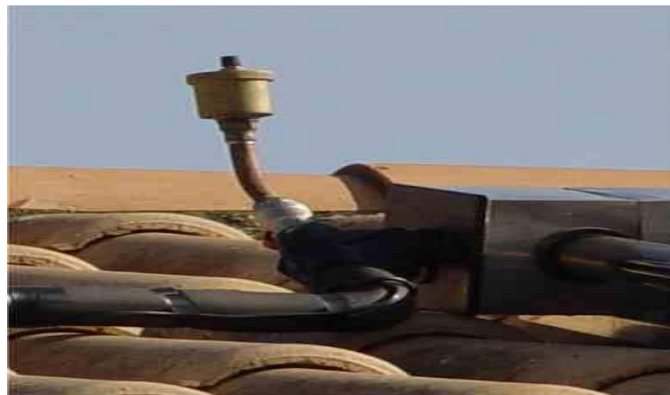
Figure (2-14) : Purgeur automatique
