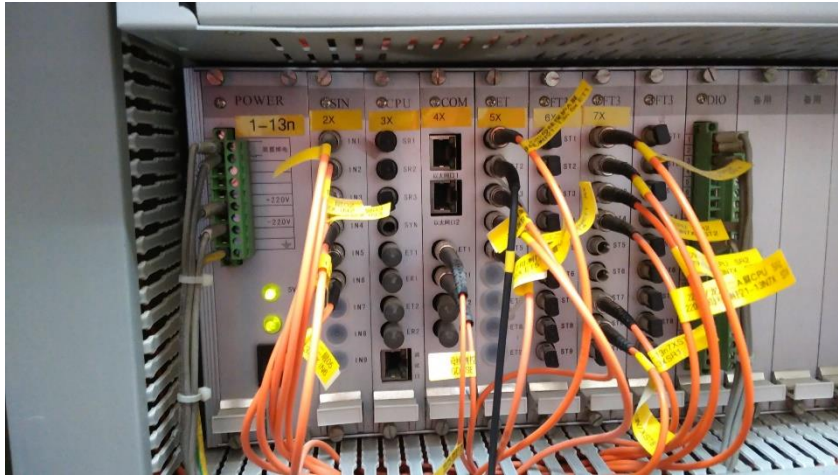
Beaucoup de câbles fibre optique connectent MU
