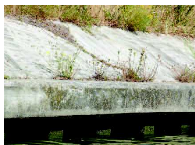
Photographie 12 Palplanches à Choisy-le-Roi
