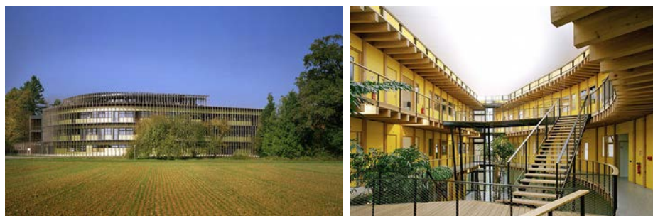
Figure 1: INRA Champenoux, Unité IAM, Bâtiment K (Araud, 2013)
