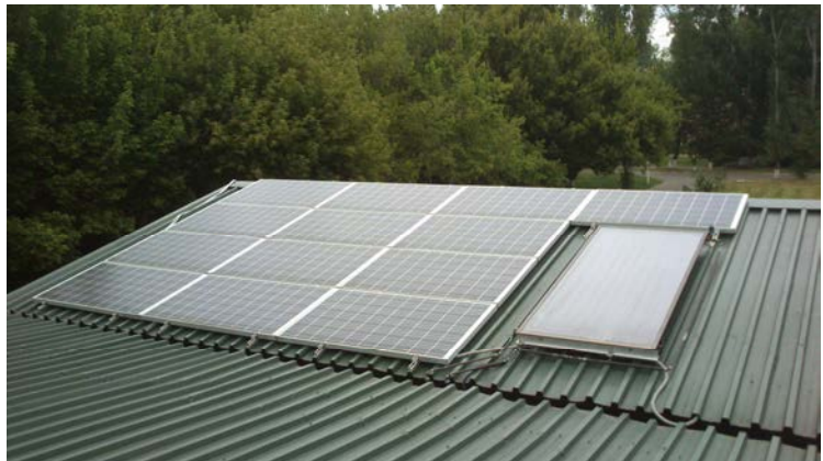
Figure 21 : Installation des panneaux solaires sur la maison passive
