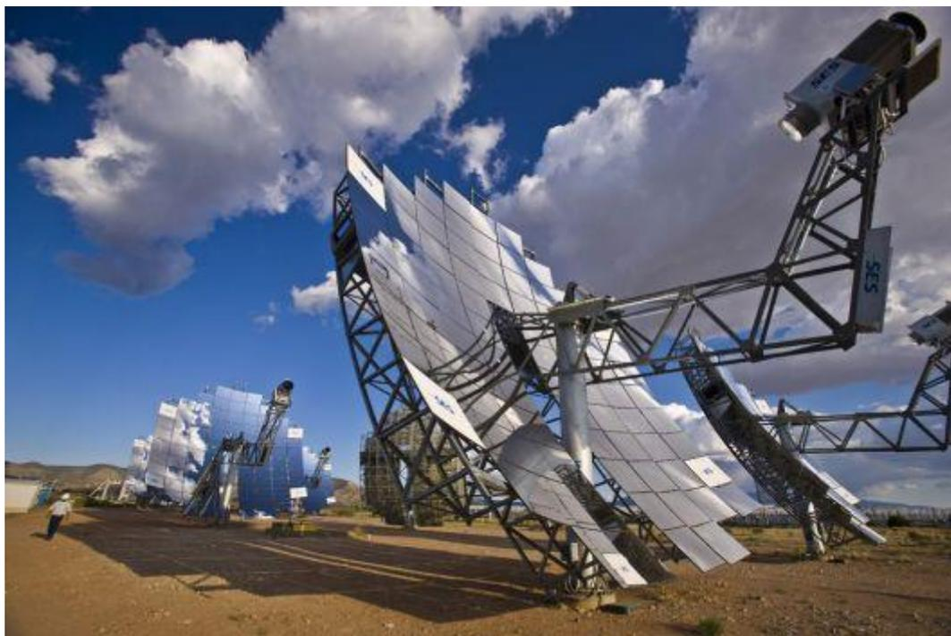
*Paraboles solaires Dish-Stirling à Albuquerque, Australie*
