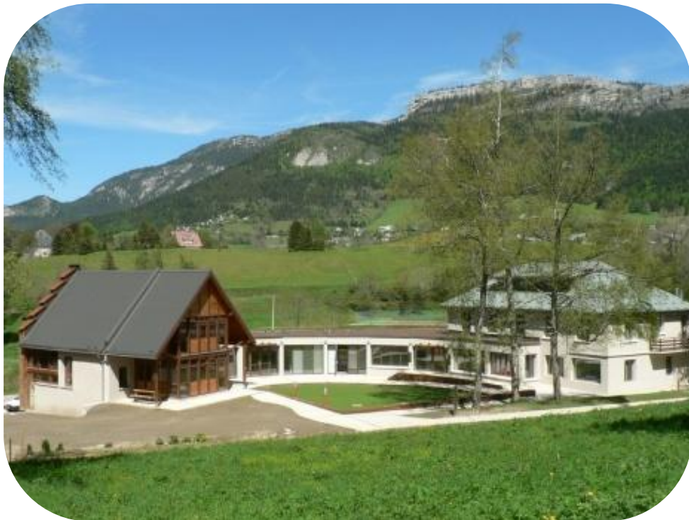
FIGURE 5: PHOTOGRAPHIE DE LA MAISON DU PARC, LANS-EN-VERCORS
