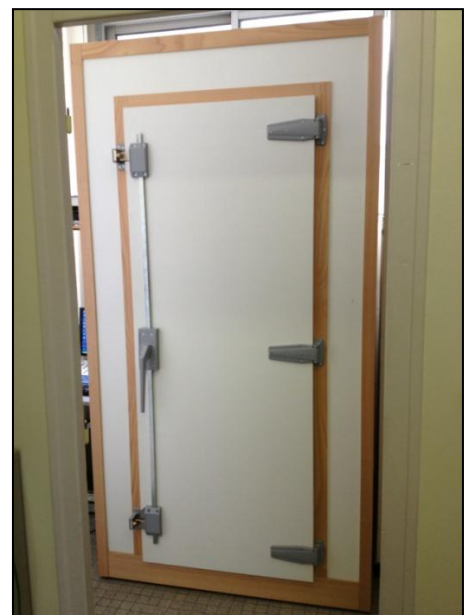
Figure 36: Cabine standard munie d'une porte isolante
