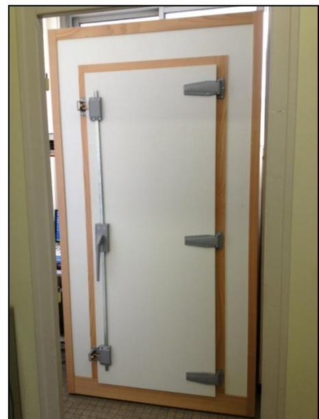
Figure 36: Cabine standard munie d'une porte isolante
