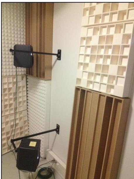
Figure 10: Matériaux isolants et diffuseurs
