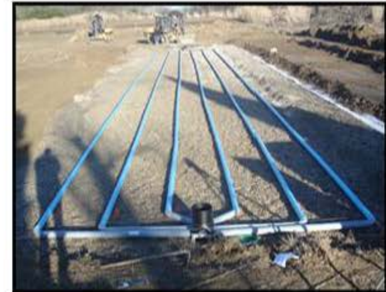
Raccordement des tuyaux entre eux
