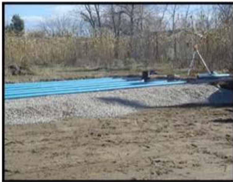
Mise en place du gravier lavé (0,30 mètre)
