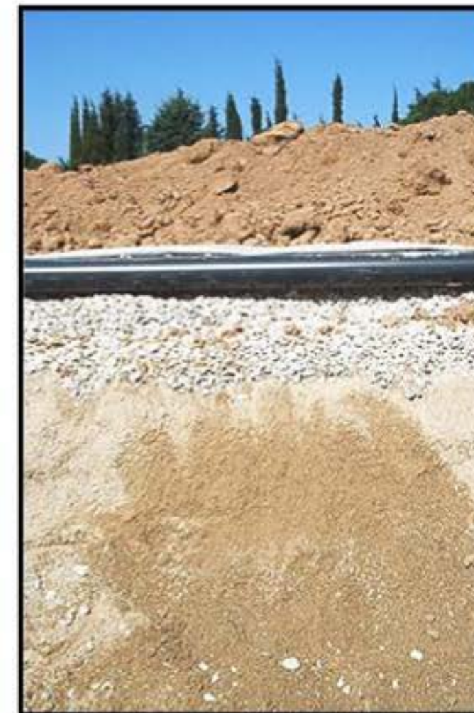
Coupe du filtre à sable non drainé
