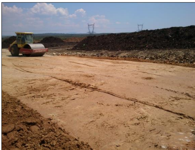
Figure 14 : Photographie de la plateforme en argiles en cours de réalisation (compactage de l'argile)
