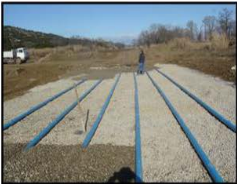
Recouvrement des tuyaux par du gravier
