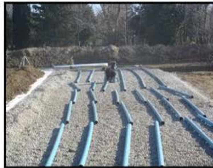
Pose des tuyaux sur le gravier lavé
