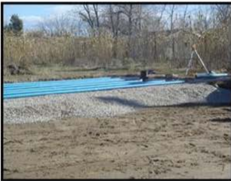
Mise en place du gravier lavé (0,30 mètre)
