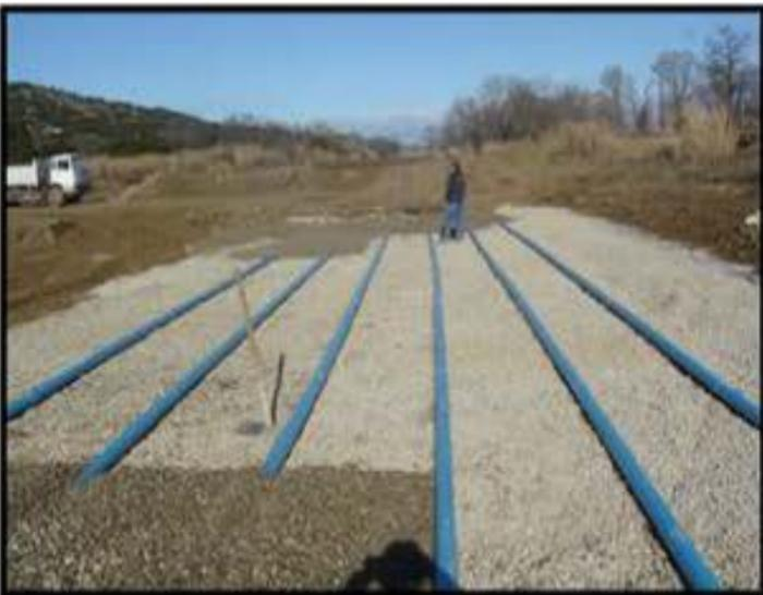
Recouvrement des tuyaux par du gravier
