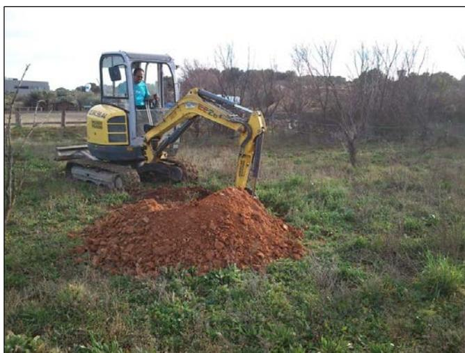
**Figure 13** : Photographie d'une pelle mécanique lors d'une étude géologique pour une future zone d'activité
