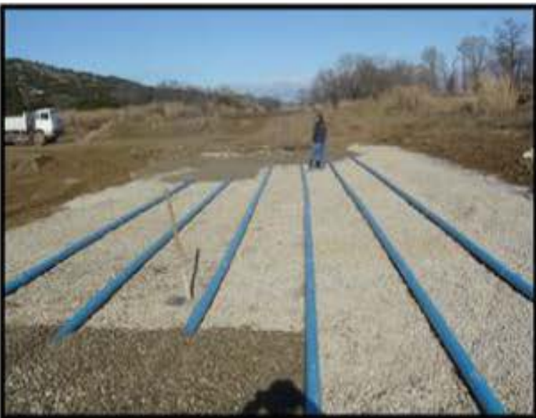
Recouvrement des tuyaux par du gravier
