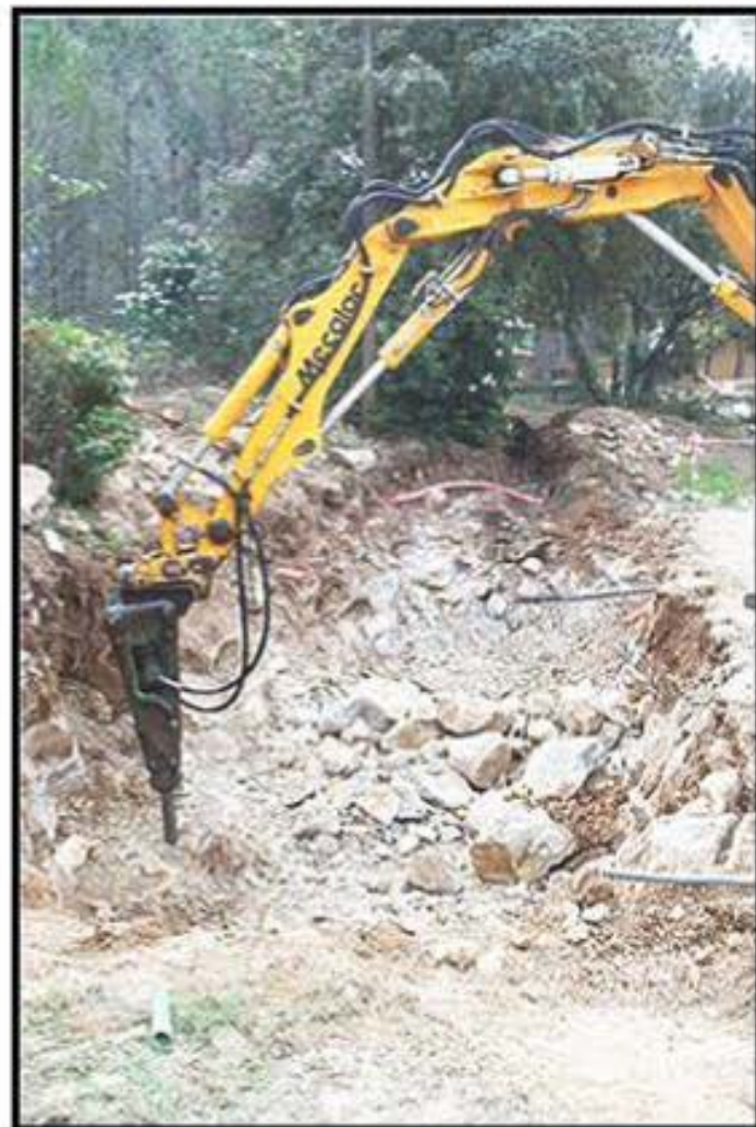
Terrassement en milieu rocheux pour la mise en place du filtre à sable - Utilisation d'un brise roche hydraulique
