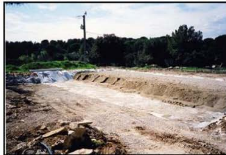
Vue du filtre à sable non drainé avec la paroi de sable
