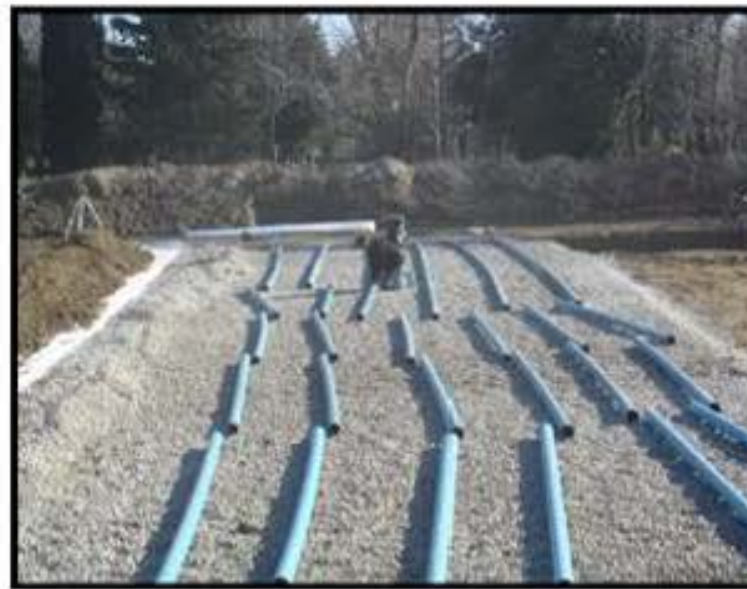
Pose des tuyaux sur le gravier lavé
