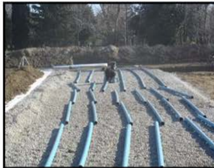
Pose des tuyaux sur le gravier lavé
