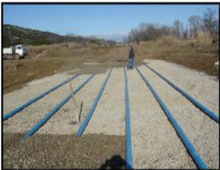
Recouvrement des tuyaux par du gravier
