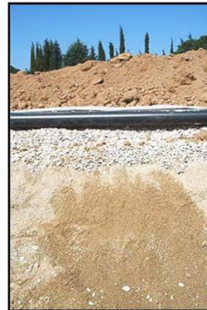
Coupe du filtre à sable non drainé
