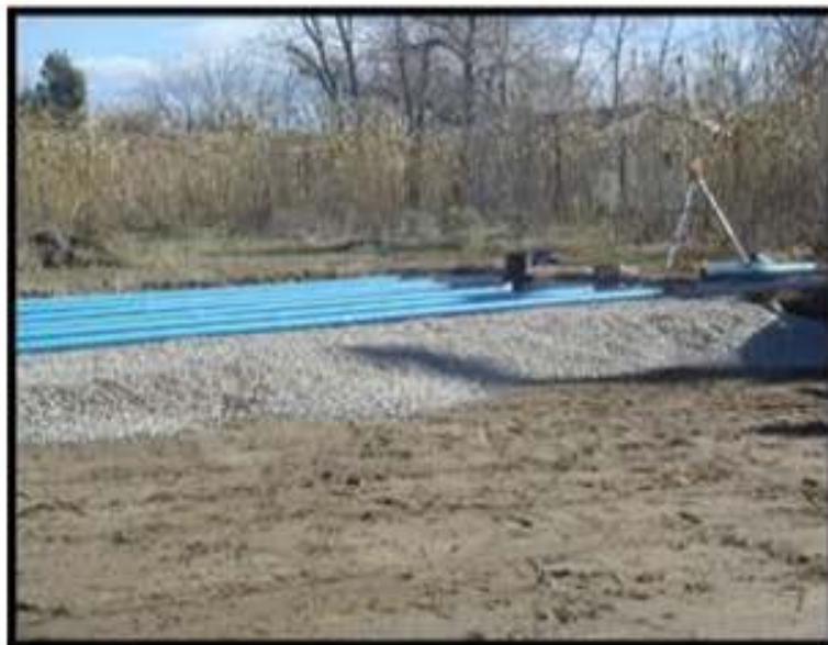
Mise en place du gravier lavé (0,30 mètre)
