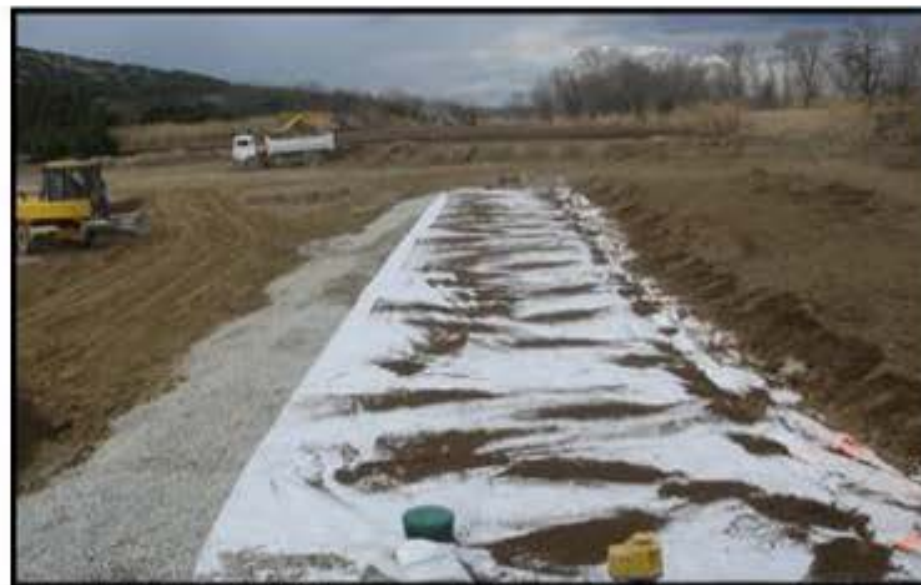
Mise en place du géotextile au dessus des graviers et de la terre végétale
