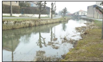
Elargissement du lit mineur dans la traversée des villages (le Terrouin à Andilly à gauche, l'Ingressin à Toul à droite) à l'origine d'une diminution du régime hydraulique et à l'envasement des fonds
