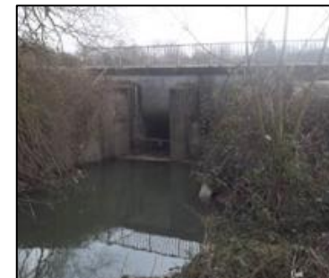
Ouvrage de rejet de l'Ingressin dans la Moselle : ouvrage de syphon/by-pass
