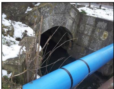
Pont de la rue de Thiaucourt
