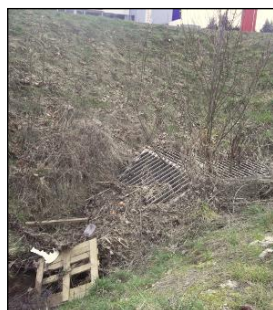
Entrée du busage du ruisseau des Embannies
