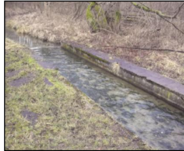
Aménagements sur berges : berges artificialisées (murs en briques ou en béton)
