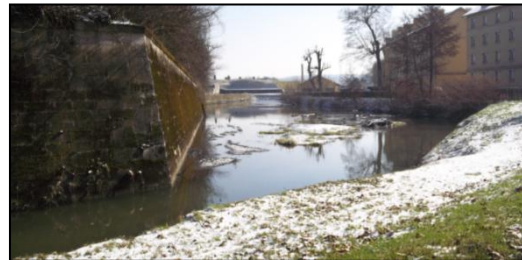
Elargissement du lit mineur dans la traversée des villages (le Terrouin à Andilly à gauche, l'Ingressin à Toul à droite) à l'origine d'une diminution du régime hydraulique et à l'envasement des fonds
