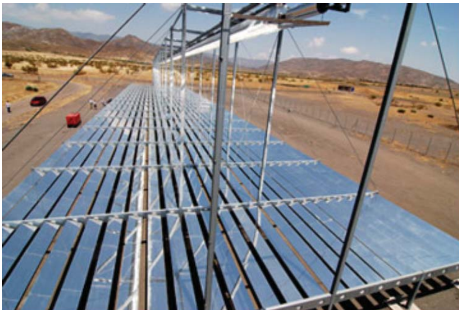
Figure 3-7 : Réflecteur de Fresnel de la centrale solaire de Fresdemo, à Tabernas en Espagne.
