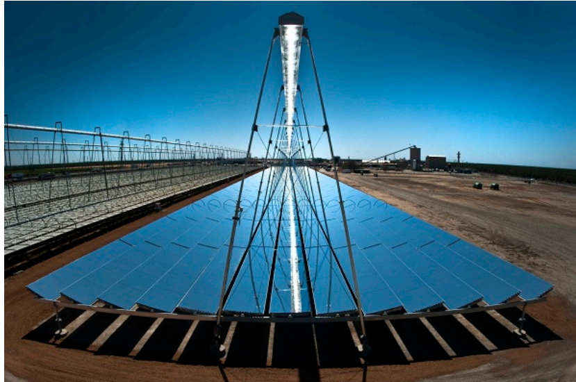
Figure 12 Centrale à miroir de Fresnel (sources: google images)
