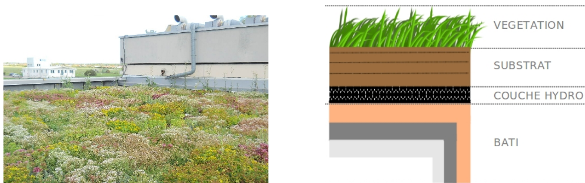
FIGURE 2.1 – A gauche, photographie des toitures végétalisées présentes au LRPC de Nancy. A droite, vue en coupe d'une toiture végétalisée avec ses principales composantes : la couche de végétation (sedum au LRPC), le substrat et la couche Hydro.
