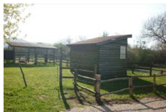
Photo 13 : Abri pour le public
