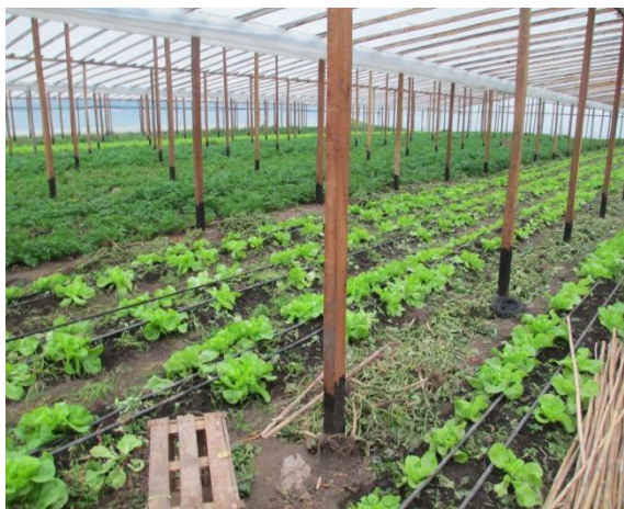
19.a Photographie 1 : Structure d'une serre (bois et polyéthylène)
