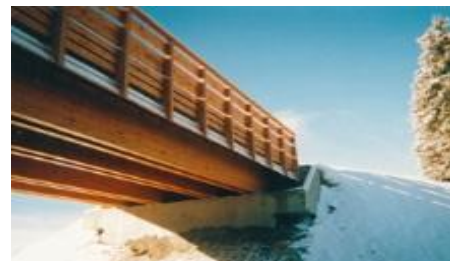
Photo 5 : Pont réalisé en bois/béton
