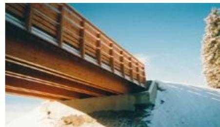
Photo 5 : Pont réalisé en bois/béton
