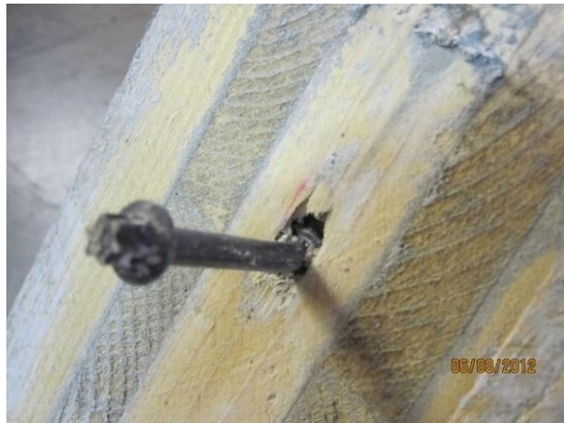
Photo 11 : Matage du bois au niveau du connecteur
