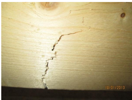
Photo 22 : Rupture du bois en traction
