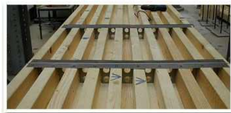
Photo 6 : Connecteurs fixés à la dalle
