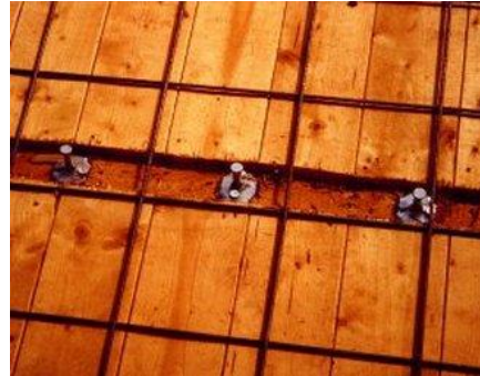
Photo 4 : Connecteurs fixés au plancher
