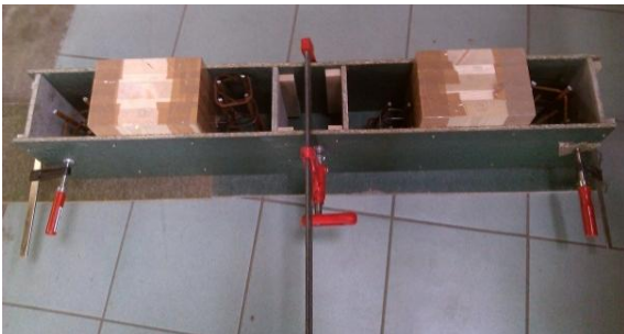
Photo 8 : Mise en place du coffrage
