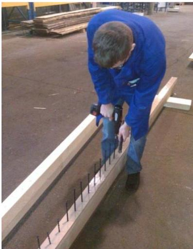
*Photo 14 : Mise en place des vis*
