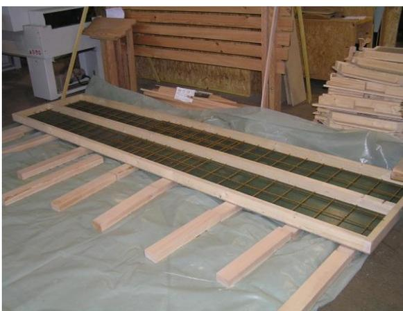
*Photo 16 : Coffrage et ferrailage*
