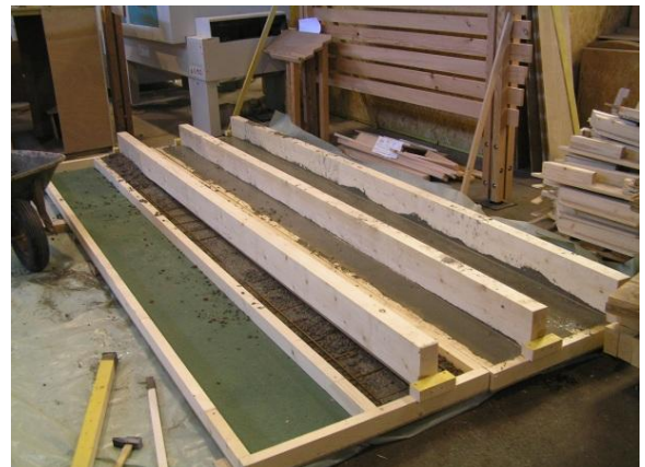
Photo 17 : Poutre en cours de bétonnage
