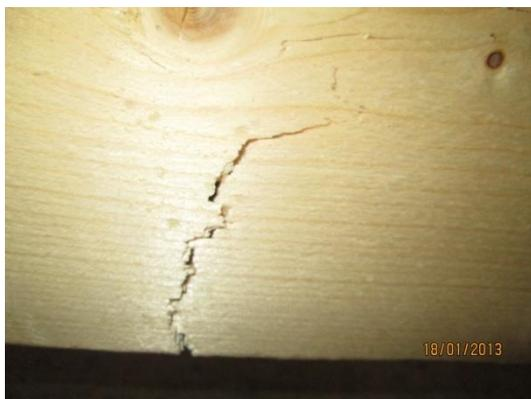
*Photo 22 : Rupture du bois en traction*
