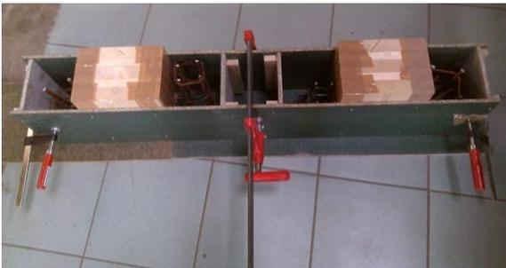
*Photo 8 : Mise en place du coffrage*
