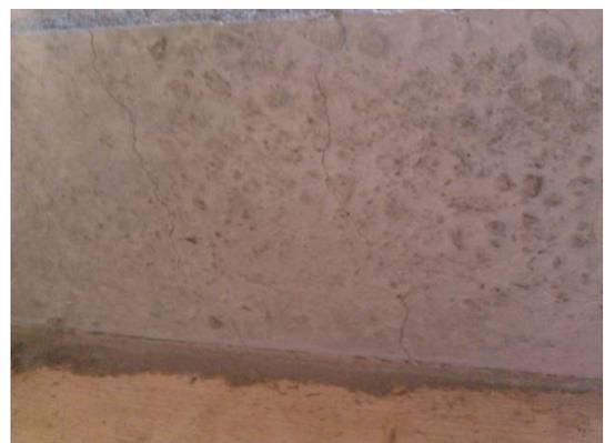
*Photo 23 : Fissuration du béton*
