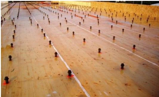
*Photo 1 : Prédalle de bois munie de connecteurs avant pose du ferrailage et du béton*
