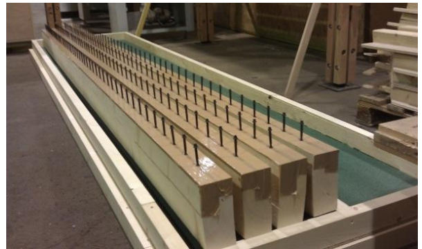
Photo 15 : Poutres et coffrages
