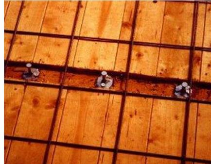
Photo 4 : Connecteurs fixés au plancher
