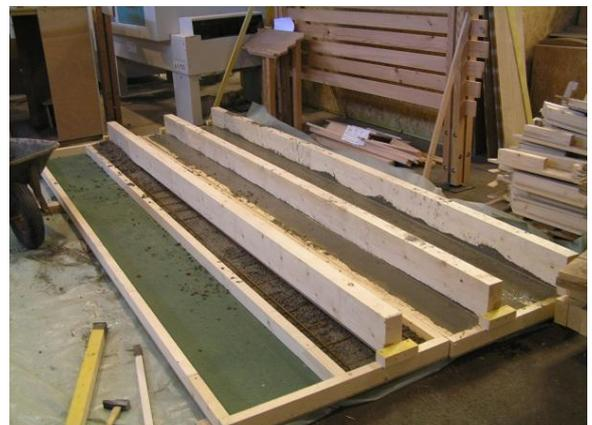
*Photo 17 : Poutre en cours de bétonnage*
