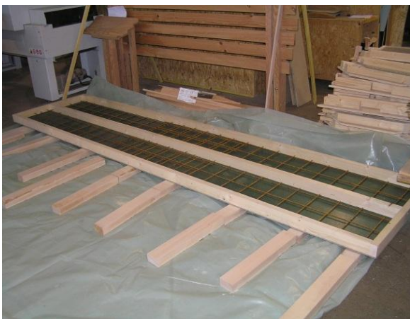
Photo 16 : Coffrage et ferrailage
