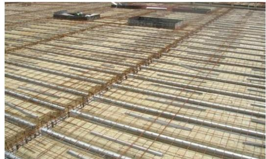
*Photo 2 : Prédalle de bois munie de connecteurs avec ferrailage, bac acier et isolant*
