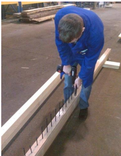
Photo 14 : Mise en place des vis
