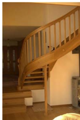
Figure 14 : Limon d'escalier en colimaçon
