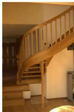
Figure 14 : Limon d'escalier en colimaçon
