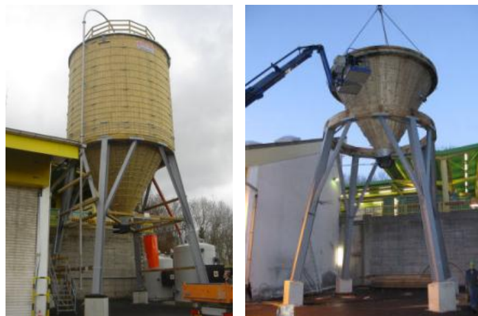
Figure 12: Silos en bois pour le stockage du sel (source : Sels-en-stock.fr)
