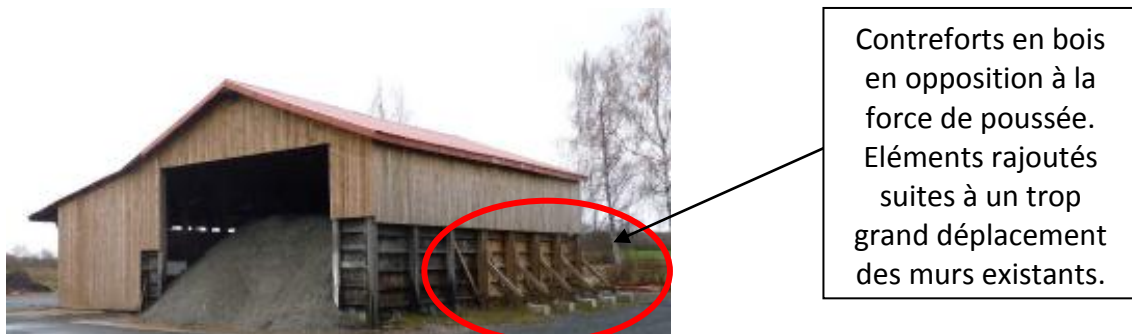
Figure 6: Contreforts en bois assurant le soutènement
