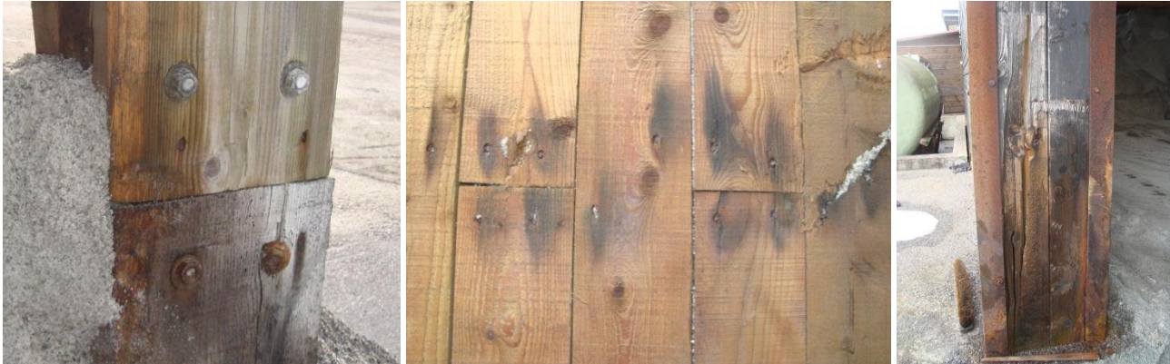
Boulons permettant la fixation du poteau moisé
