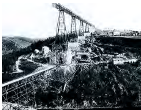
Figure 8 : Montage du tablier simultanément au montage des piles
