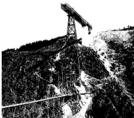
Figure 7 : Montage de la première pile
