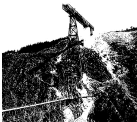
Figure 7 : Montage de la première pile
