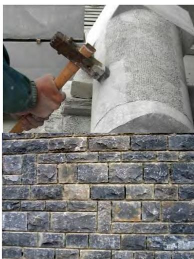
Figure 6 : Travail des moellons à la boucharde
