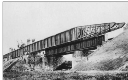
Illustration 16 : Ponts portatifs démontables
